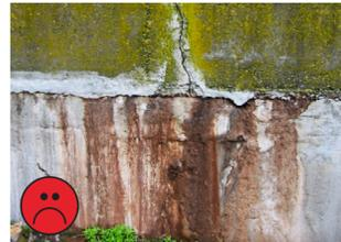
Le lisier s'échappe visiblement à travers les fissures du réservoir.
